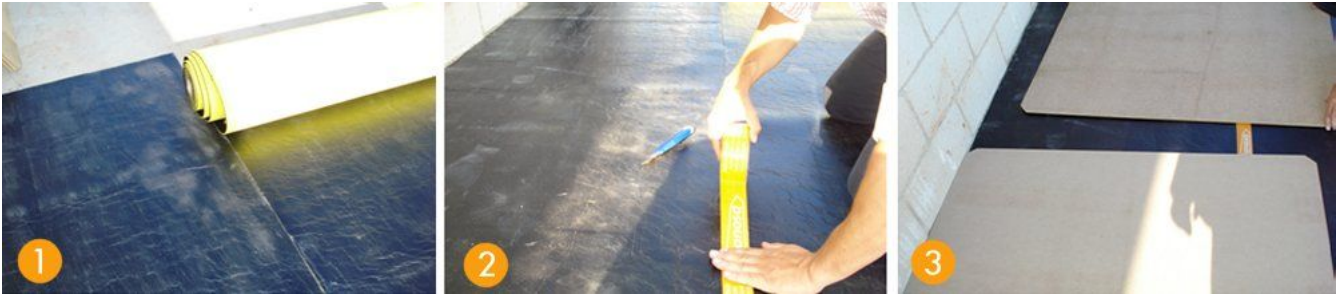
Extender. Sellar solape. Colocar suelo flotante seco.
